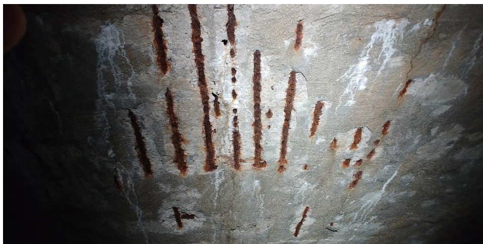
Obr. 24. Prosakující místa a výluhy v místě trhlinek a dutin. Krytí výztuže vrchní stěrkou místy jen 2mm.
