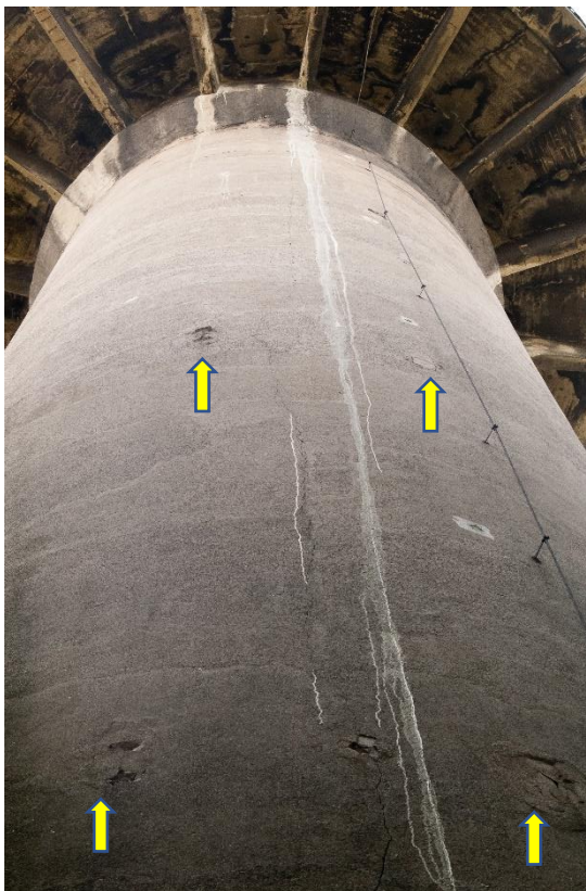
Obr. 4. Viditelné vetknutí vnitřních kovových profilů, zde v 2.NP a 3.NP.
