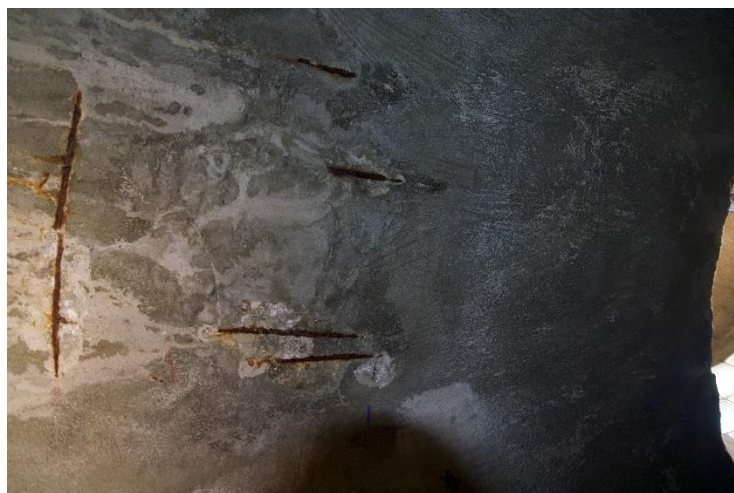
Obr. 18. Odpadnutí krycí vrstvy betonu a vrchní jemnozrné reprofilační vrstvy, pokročilá laminární koroze výztuže. Opět viditelné stopy po pronikání vody.
