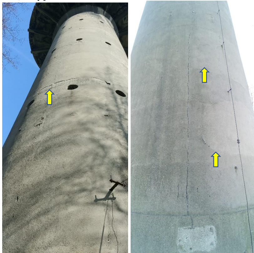
Obr. 8. Celkový pohled na vnější část dříku: z jižní strany (vlevo) a západní strany (vpravo). Viditelná místa po opravách cementové omítky.
