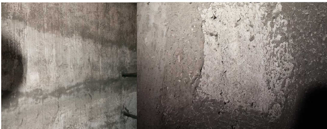
Obr. 10. Viditelné provedení předchozí sanace, vynechané místo při předchozí sanaci
