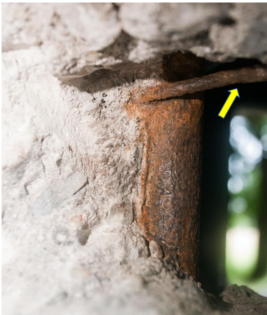
Obr. 16. Sekaná sonda v místě vertikální výztuže dříku (a v místě blízkosti významné trhliny). Zúžení profilu horizontální výztuže na 7.3mm a v místě trhliny na celkových 6mm.
