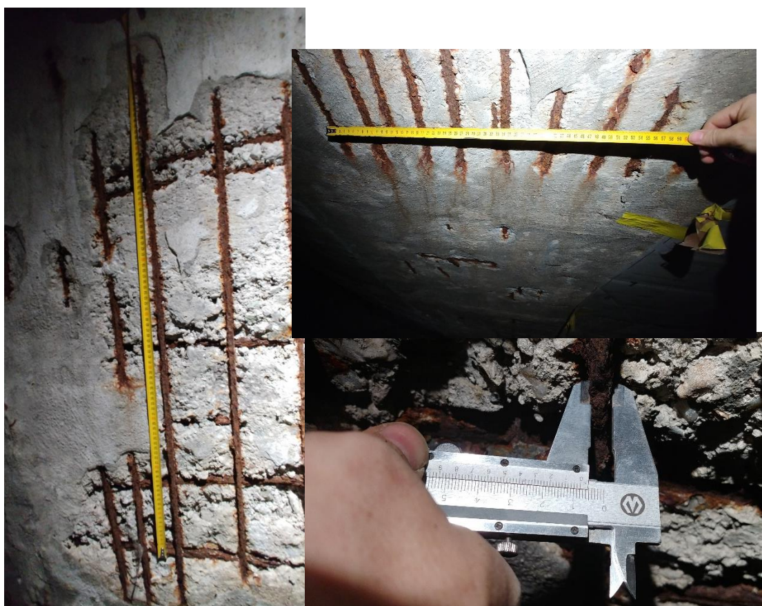
Obr. 25. (Vlevo) Aplikovaná jemnozrnná hmota jako krytí výztuže, (Vpravo nahoře) vyplavující se korozní produkty obnažené vertikální výztuže, (Vpravo dole) Oslabení průřezu výztuží až o 50%.
