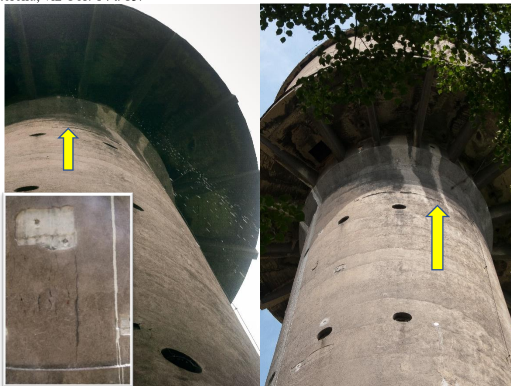
Obr. 15. Jihovýchodní část VV - nad vchodem. (Vlevo) Protékání srážkové vody při dešti skrz střešní konstrukci a následně přes ŽB desku na konzolách. (Vlevo dole) Detail nad soklem na západní straně dříku. (Vpravo) Biologické narušení omítky (sinice) v místě horizontální trhliny vlivem dotace vody při deštích skrz vrchní ŽB desku.
