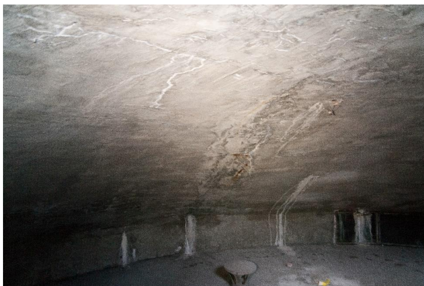
Obr. 17. Pohled na skořepinu, viditelné stopy po pronikání vody systémem trhlinek v betonu
