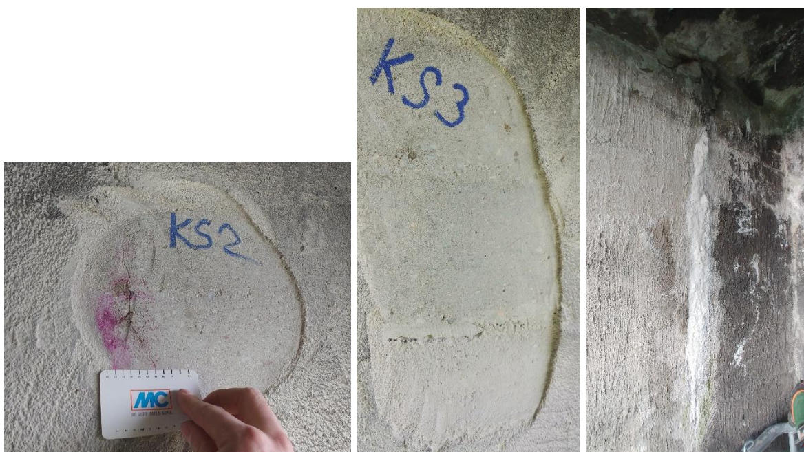
Obr. 22. a) Vertikální trhlina, tl. 0,7 mm (vlevo) b) Viditelné pracovní spáry v betonu (uprostřed) c) Vyluhování v místě zatékání, v místě vertikální výztuže typu ROXOR, nahoře již je vidět odpadávání povrchové vrstvy betonu vlivem výrazné koroze výztuže.
