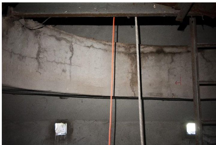
Obr. 11. Boční pohled na vnitřní část desky D27 a trhliny v místě uložení výztuže
