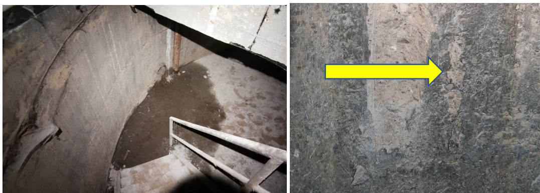
Obr. 5. Pronikání vlhkosti do 1.PP (vlevo) a příklad místa s odlupující se vrchní vrstvou betonu a reprofilační stěrky/nátěru
