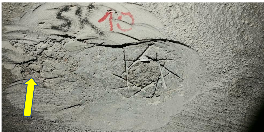
Obr. 20. Viditelná hrubá struktura betonu s velkými kavernami a dutinami zejména v okolí výztuže. Viditelné až po obroušení vrchní jemnozrné reprofilační vrstvy. Na fotce je rovněž viditelná horizontální výztuž bez krytí původním betonem.
