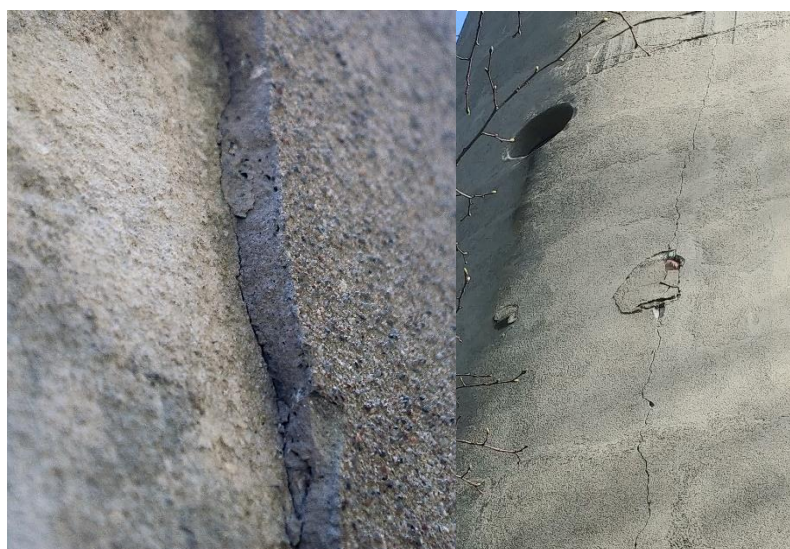
Obr. 9. Detailní pohled na styk povrchu betonu s cementovou omítkou (vlevo) a detail viditelného uložení ocelového profilu v 1.NP.(vpravo).
