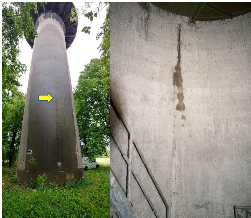
Obr. 13. Pronikání srážkové vody skrz průběžnou trhlinu z exteriéru (vlevo) do interiéru (vpravo) na západní části dříku v 1.NP.
