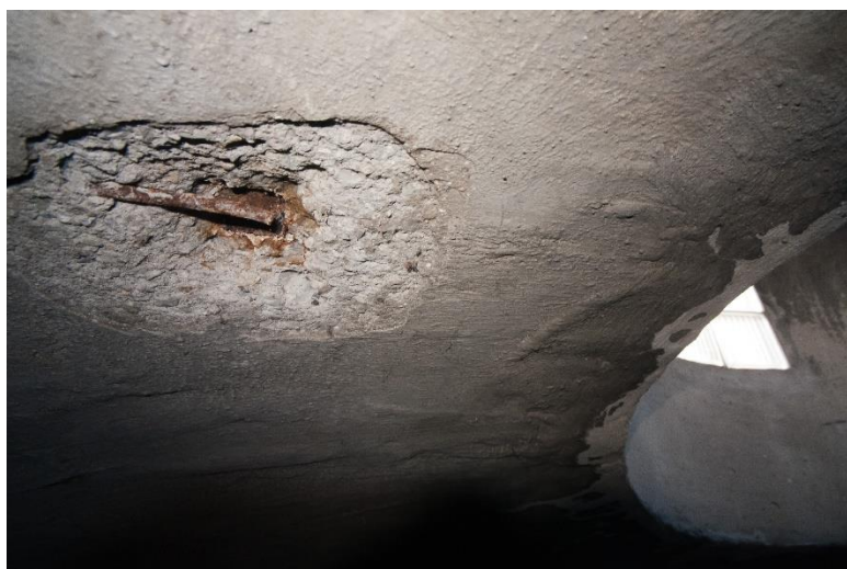
Obr. 19. Odpadnutí vrchní vrstvy betonu vlivem bobtnání dřeva. Viditelné ukončení jedné z prutových výztuží 35 cm od vnitřního okraje skořepiny.
